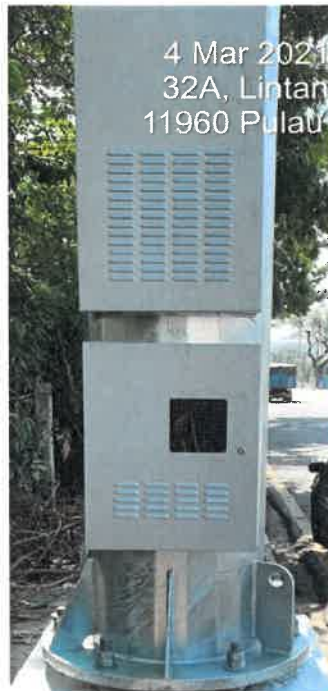
Rajah 1 menunjukkan pandangan sisi hadapan bagi penetapan lokasi panel smart meter TNB di struktur tiang
